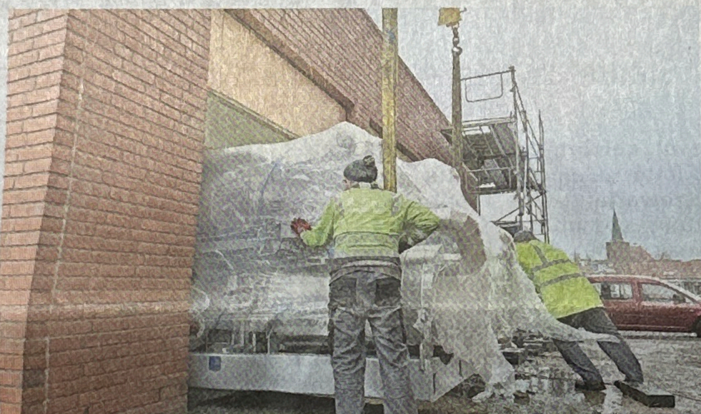
Die Meerwasser-Wärmepumpe wird mit Unterstützung der Arbeiter ins Gebäude gehievt.
