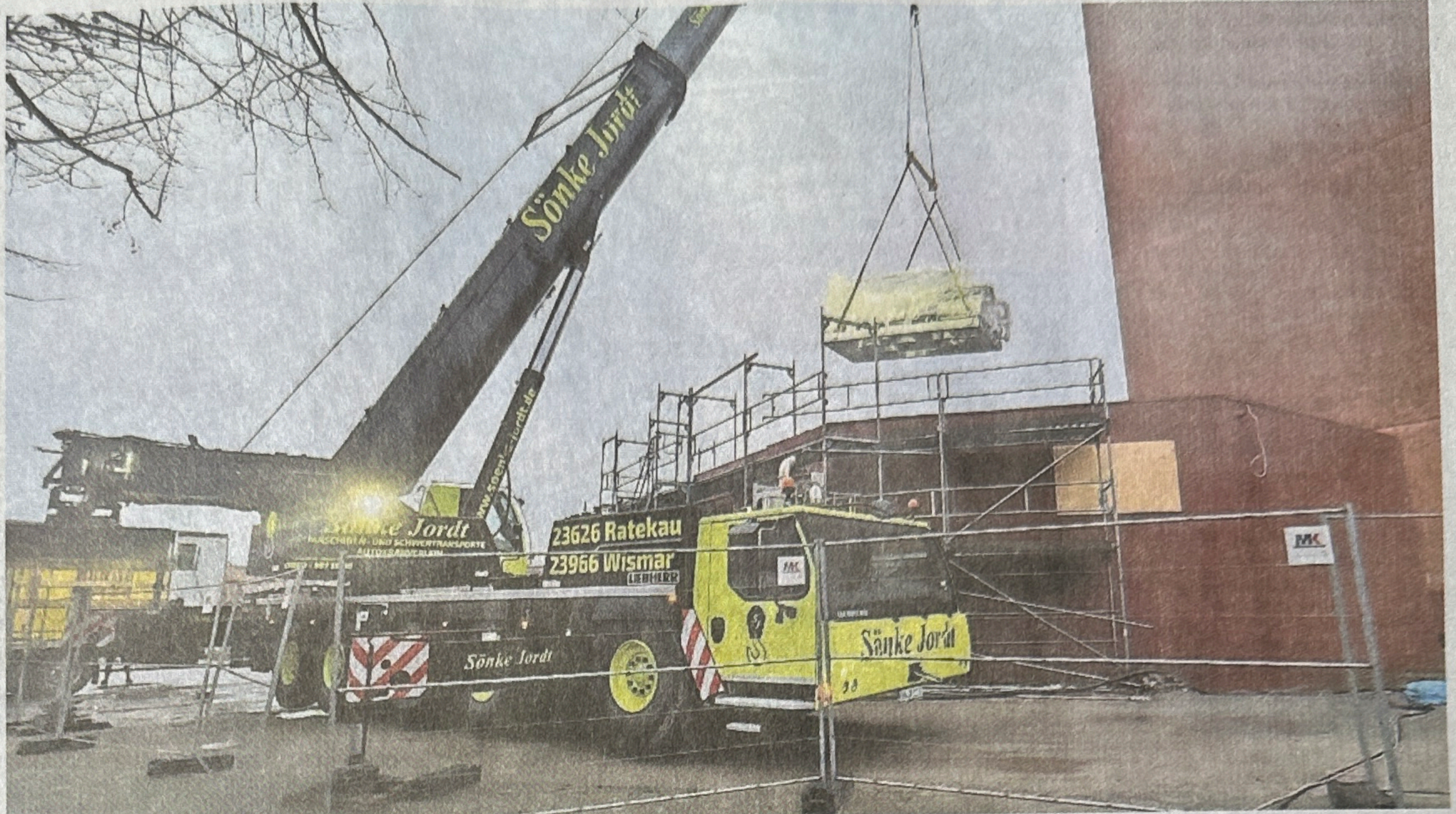
Die Meerwasser-Wärmepumpe ist da. Gestern wurde das Gerät am Vormittag per Lkw an der Hafenseite angeliefert und mit Hilfe eines Krans in die Energiezentrale gebracht.
